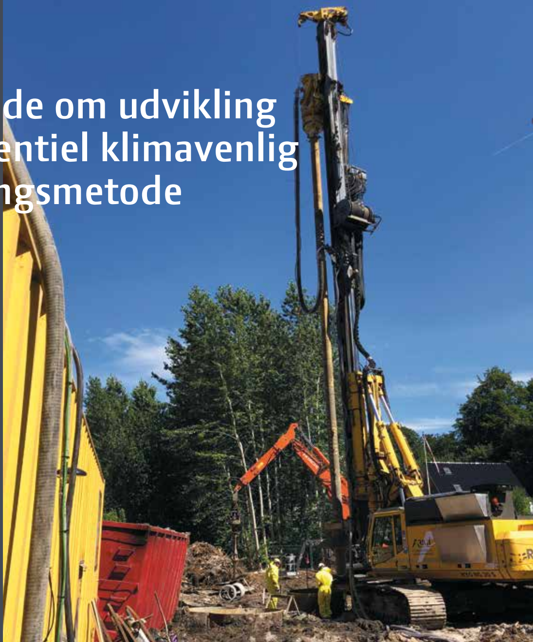
Oprensning på Søllerød Gasværk, 2018
