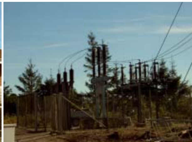
Oliekølet transformere
