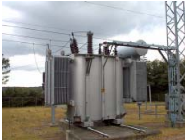
Oliekølet transformere
