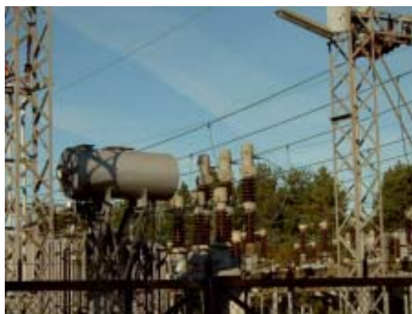
Oliekølet transformere
