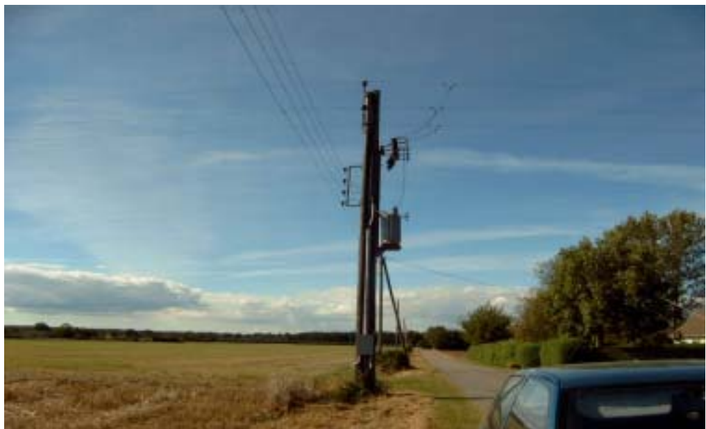
Figur 3.9 Eksempel på en mastestation.
