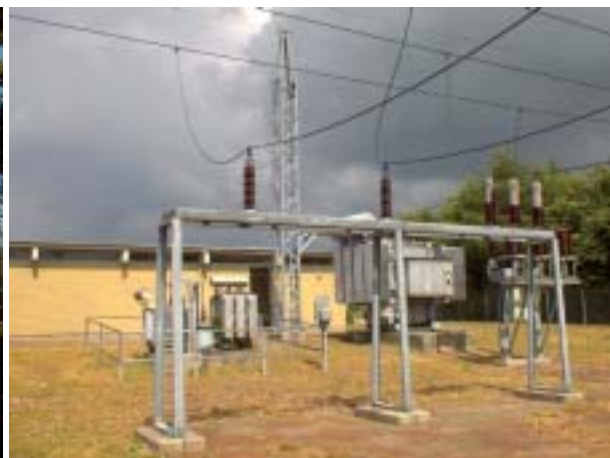
Friluftstransformerstation (mellem)
