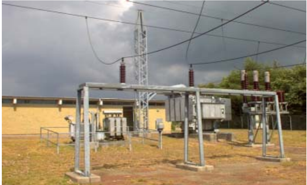
Figur 3.6 Eksempel på en friluftstation.
