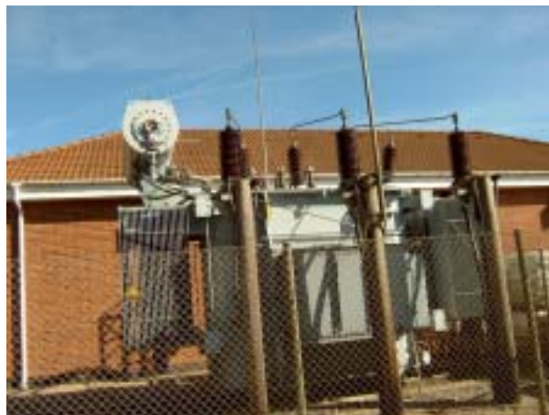
Oliekølet transformere
