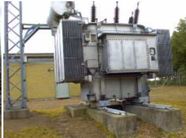
Oliekølet transformere
