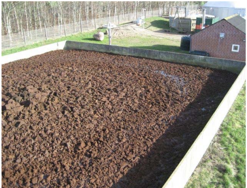
Figur 4-2 Slamlagertank for afvandet spildevandsslam.
