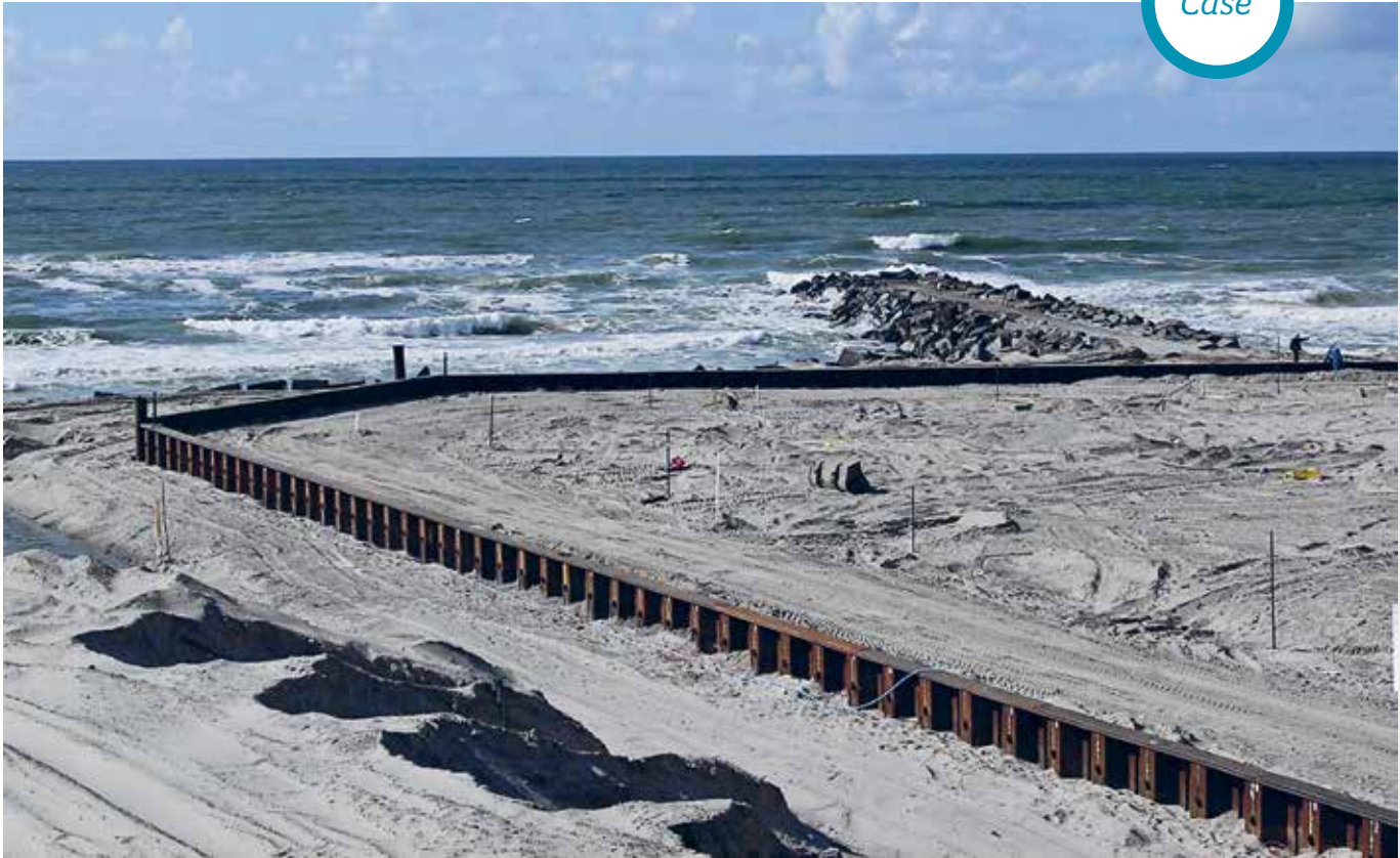
August 2006, depotet ved Højde 42 bliver indkapslet med en jernspuns.
