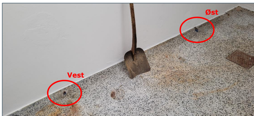
Figur 3.3. Lokaliserede jernrør i gulvkonstruktion i bryggers (røde markeringer).
