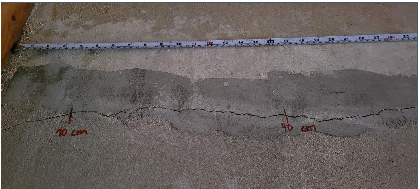
Figur 3.1. Revne ved ydervæg i stue under gulvtæppe. Revnen er tidligere udbedret, hvilket ses at det mørkere spartlede område.
