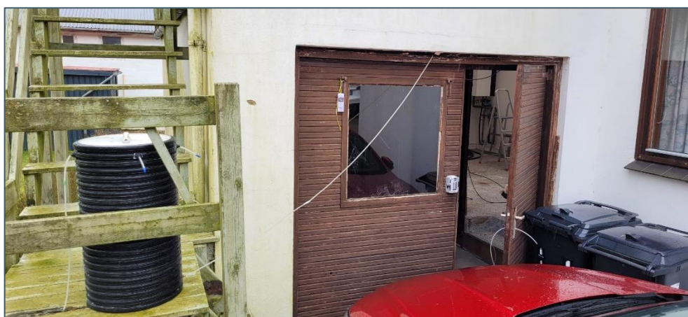
Figur 4.9. Foto set fra udvendig side af carport og ind i bryggers, svarende til den primære udluftningsvej for blowerdooren. Yderligere ses 'tryk-absorbent' som den sorte tønne i venstre del af fotoet.
