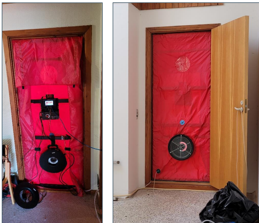
Figur 4.8 Blowerdoor: Foto til venstre set fra gangen (indefra) og foto til højre set fra bryggers (udefra).
