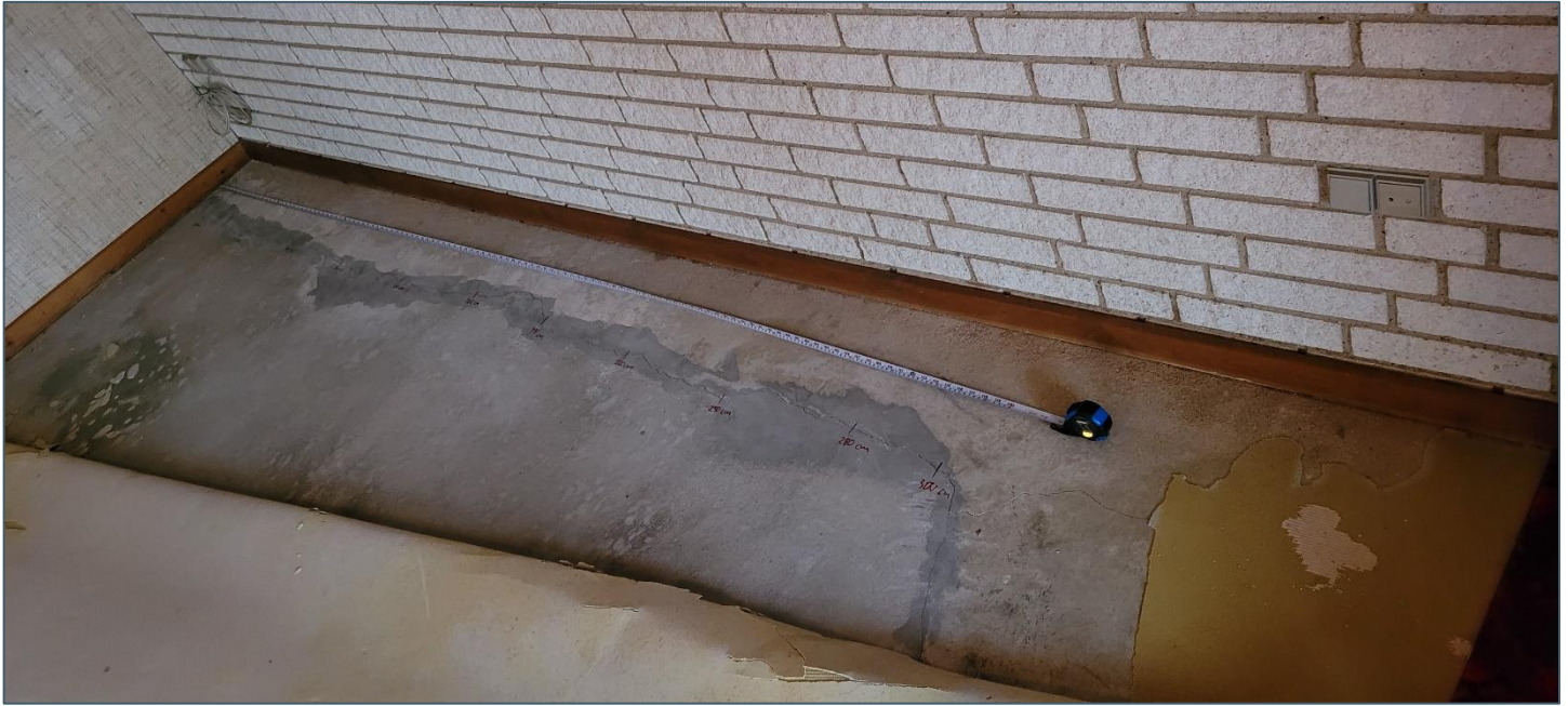
Figur 3.1. Revne ved ydervæg i stue under gulvtæppe. Revnen er tidligere udbedret, hvilket ses at det mørkere spartlede område.
