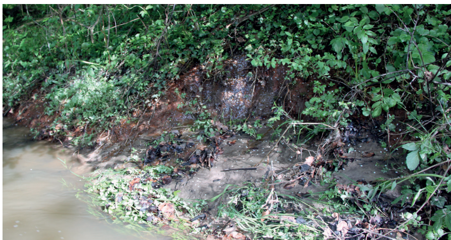
Udsivning af jernholdigt perkolat fra losseplads til overfladevand. Foto: Region Syddanmark
