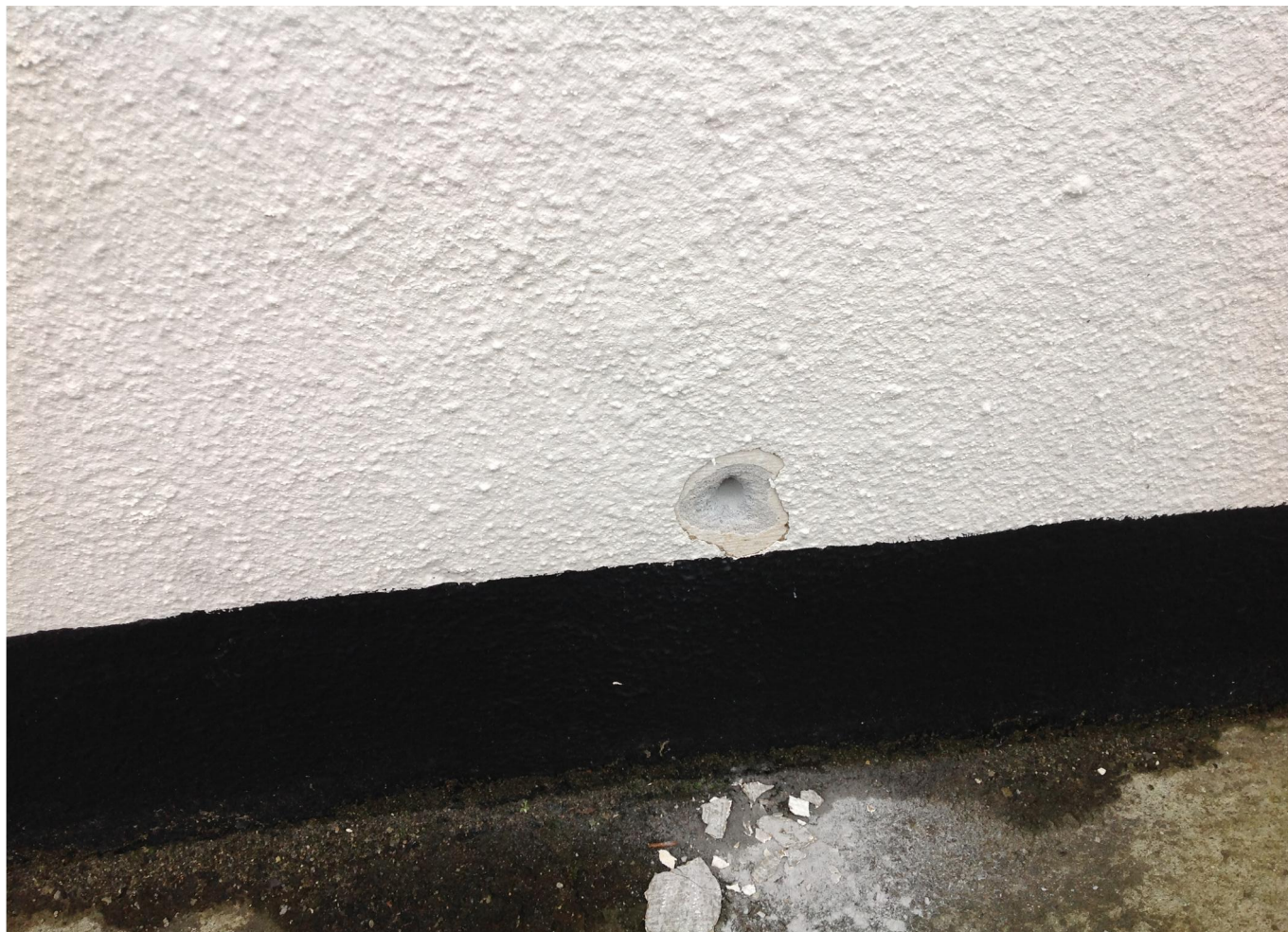
Udgangshul for måling af differenstryk ude/inde.
