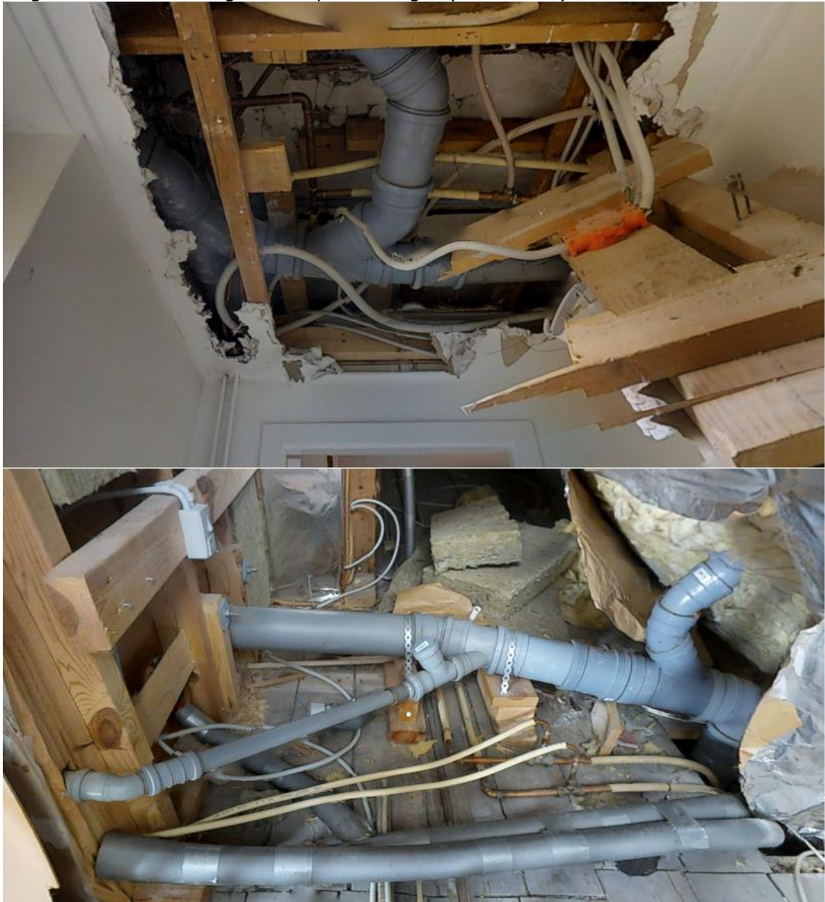
Figur 4: Eksempler på detailbilleder af afløbsinstallationer.
