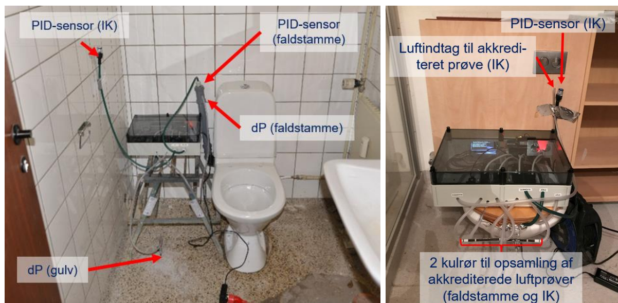
Figur 4.1 Til venstre: Gulvmonteret prøvetagnings-WC (WC1), med påmonteret installationsrør (på venstre side af cisternen) og automatisk prøvetagningsenhed. Til højre: Automatisk prøvetagningsenhed tilsluttet væghængt WC på 1. sal.
