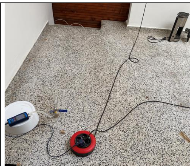
Foto 7: MP1011, som anvendes til injektion ved test 2.
