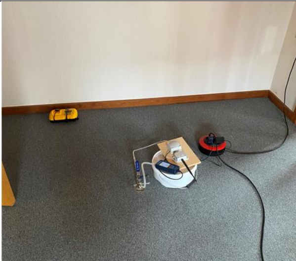
Foto 5: MP1004, hvor der ved logning ses påvirkning af differenstryk ved test 1.
