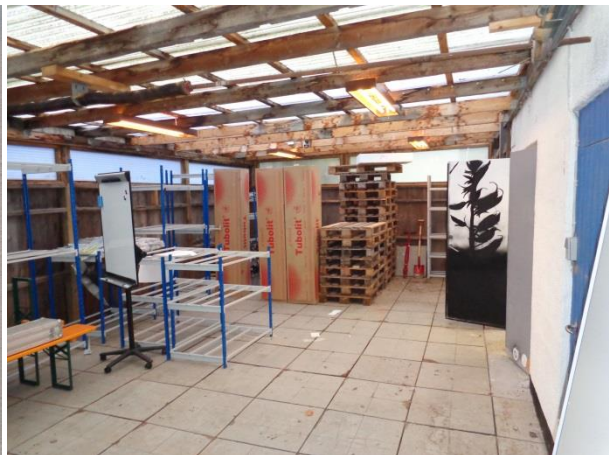
Billede 52: Garagetilbygning mod nord.
