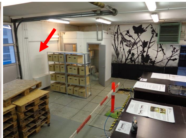
Billede 36: Skifte i gulv kvalitet fra støbt beton foran port (forgrund) til vinylfliser i stålrammer på flisefødder (baggrund). Døre til WC'er og afblændet port (i baggrunden).
