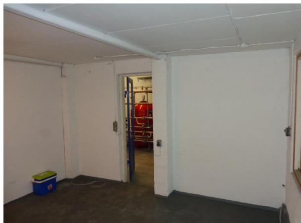
Billede 52: Dør til rum med vandrenseanlæg (fra sydtrum i vestlig ende af bygning I).
