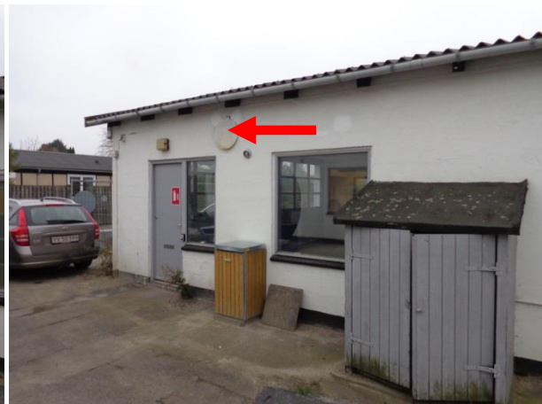
Billede 16: Nordside af bygning I. Indgang og ventilator.
