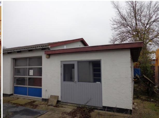
Billede 10: Nordside af bygning I. Tilbygning.
