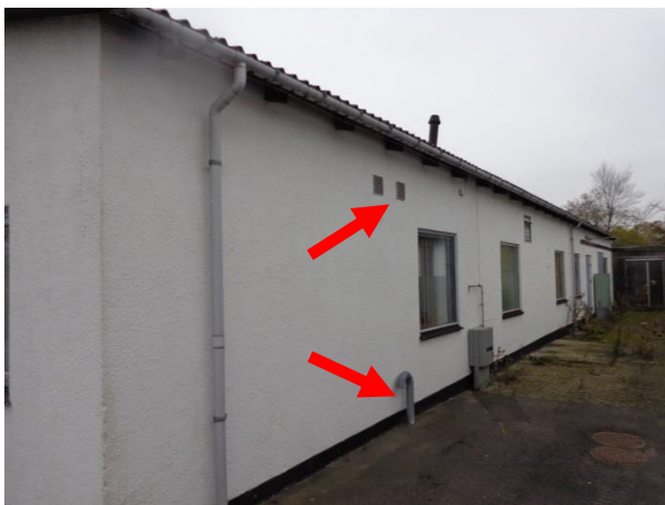
Billede 9: Nordside af bygning II. Svanehals og trækkanaler fra køkken.
