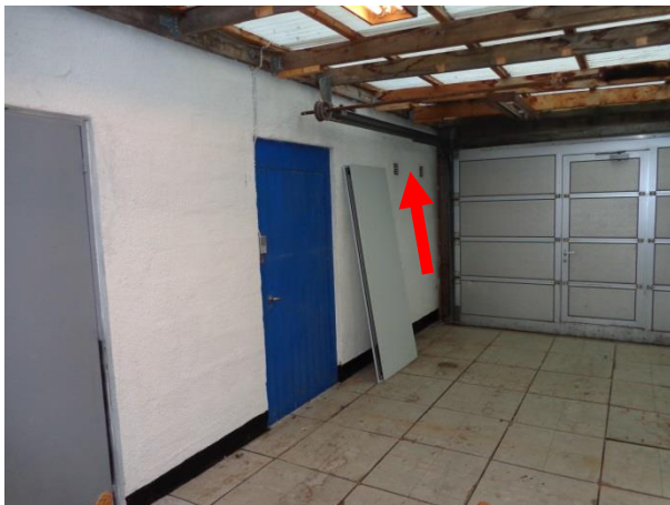
Billede 53: Garagetilbygning og døre mod "Innovationsgaragen". Trækkanaler fra WC'er.
