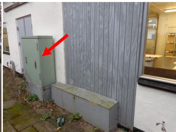
Billede 16: Nordside af bygning II. Afblændet dør og afværgeskab.
