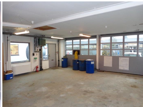
Billede 18: Indgangsparti og porte i østrum af bygning I.
