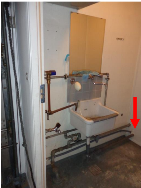
Billede 57: Håndvask på WC i den vestlige ende af bygning I. Rørgennemføringer til østlig afløb fra returskyl på vandrenseanlæg.
