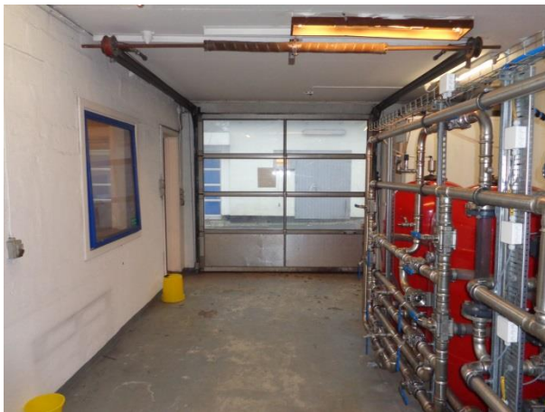
Billede 49: Port til rum med vandrenseanlæg.
