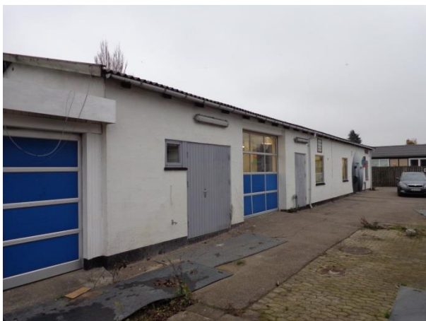
Billede 5: Sydside af bygning II.
