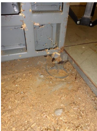
Billede 38: Close-up af opbygningen af gulvkonstruktionen med vinylfliser i stålrammer på flisefødder.
