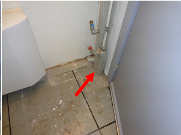
Billede 50: Rørgennemføringer til vandrør.
