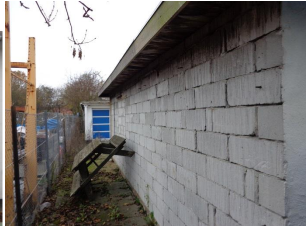
Billede 8: Vestgavl af bygning I.
