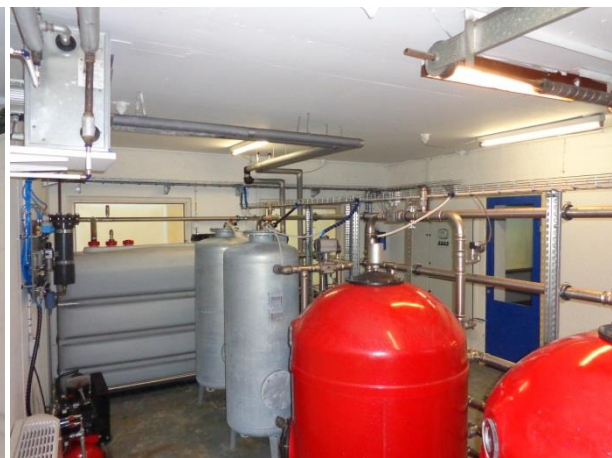
Billede 44: Vandrenseanlæg og dør til sydligt rum i den vestlige ende af bygning I.
