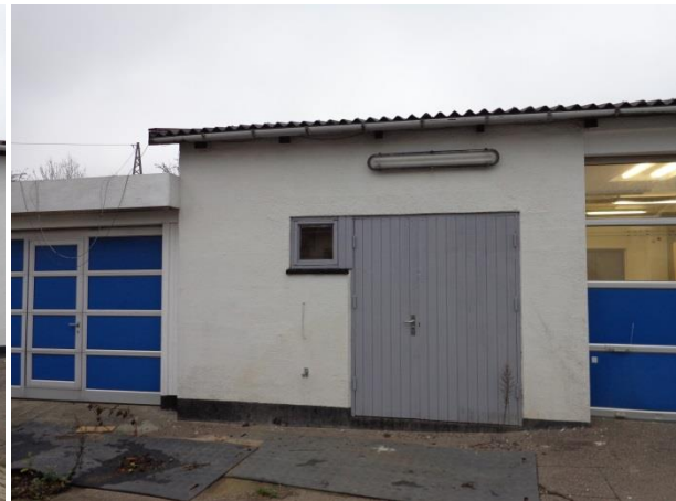
Billede 4: Sydside af bygning II. Afblændet port.
