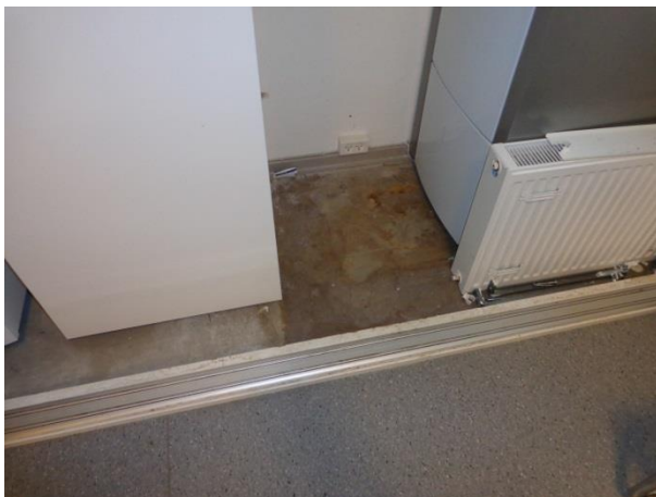
Billede 23: Gulv ved varmeinstallationer.
