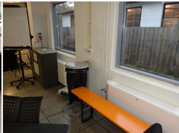
Billede 34: Vinduesparti på nordside.
