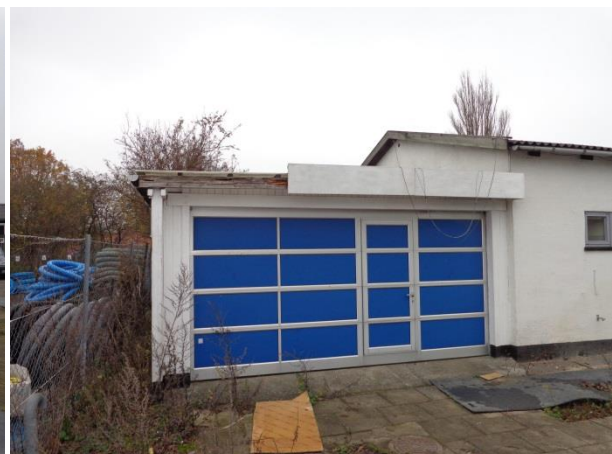
Billede 6: Sydside af bygning II. Garagetilbygning.
