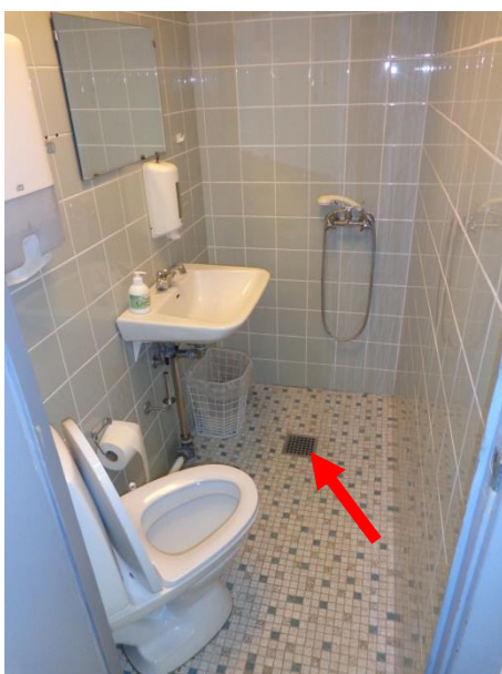
Billede 47: WC, bad og gulvafløb (GA).
