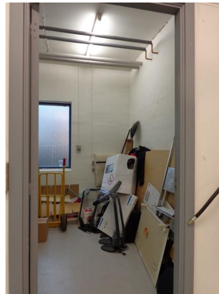
Billede 28: Pulterum med vindue mod nord og varmerør under loft. Rørgennemføringer fra installationer i køkken (billede 19).
