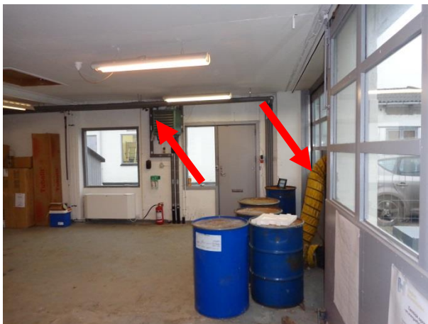
Billede 17: Indgangsparti i østrum af bygning I. Ventilator og afkastslange markeret.
