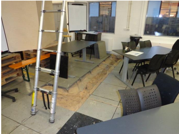
Billede 43: Bygning II, gennembrydning af gulvkonstruktion i nordside (mod nord).
