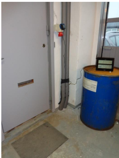
Billede 25: Rørgennemføringer til varme til højre for indgangsparti.
