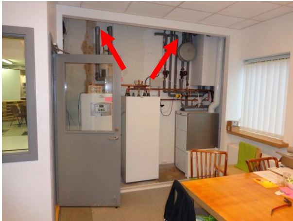
Billede 19: Indgang til køkkenet. Varmeinstallationer med rørgennemføringer ved loftet. Vindue på nordside af bygning II.
