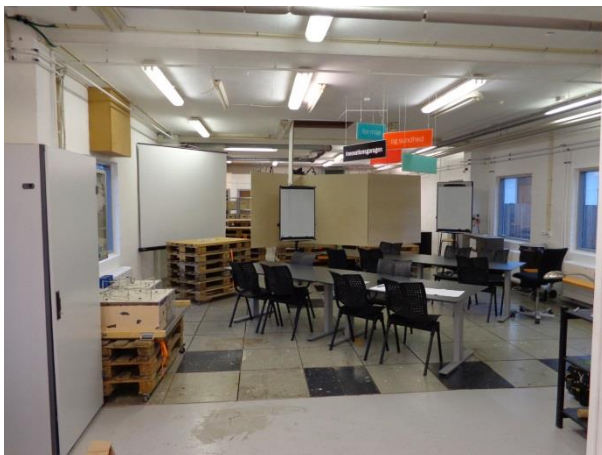
Billede 35: Skifte i gulv kvalitet fra pladegulv på strøer (forgrund) til vinylfliser i stålrammer på flisefødder (baggrund).
