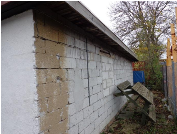
Billede 9: Vestgavl af bygning I.
