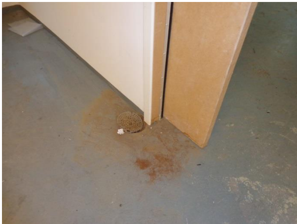
Billede 37: Gulv afløb (GA) ved dør imellem østrum og centralt rum i bygning I.
