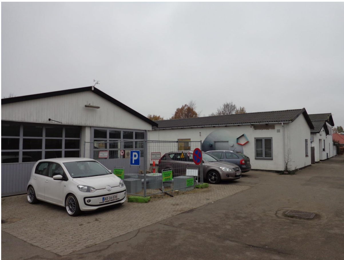
Figur 1. Foto fra indkørsel. Sydbygning til venstre (bygning I) og nordbygning til højre (bygning II).
