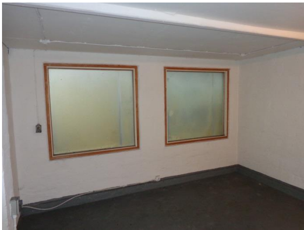
Billede 55: Vinduesparti i sydrum i den vestlige ende af bygning I.
