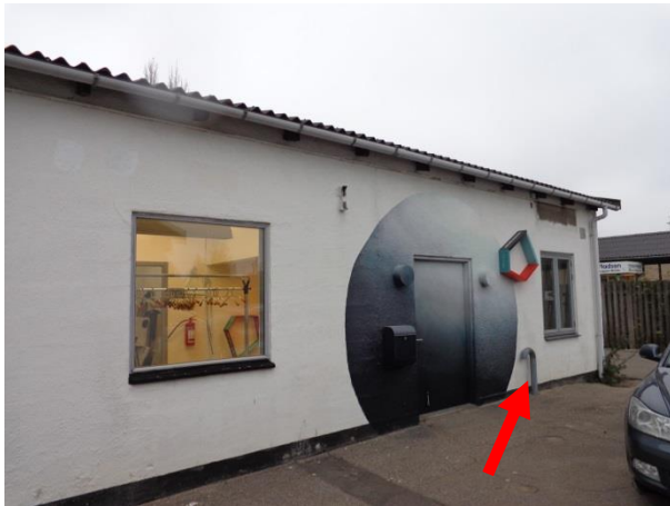
Billede 1: Sydside og indgang til nordbygningen (bygning II). Svanehals.
