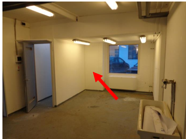
Billede 34: Håndvask i centralt rum i bygning I. Lille rum og vindue på sydside af bygning I. Bemærk "kasse" imellem vindue og lille rum.
