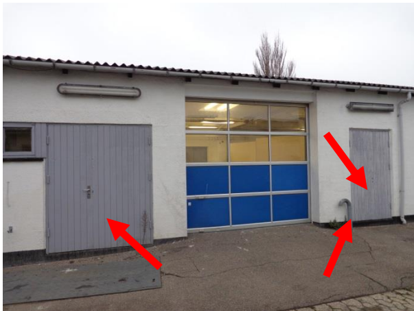
Billede 3: Sydside af bygning II. Afblændet port og dør. Svanehals. Funktionsdygtig port i midten (blå).
