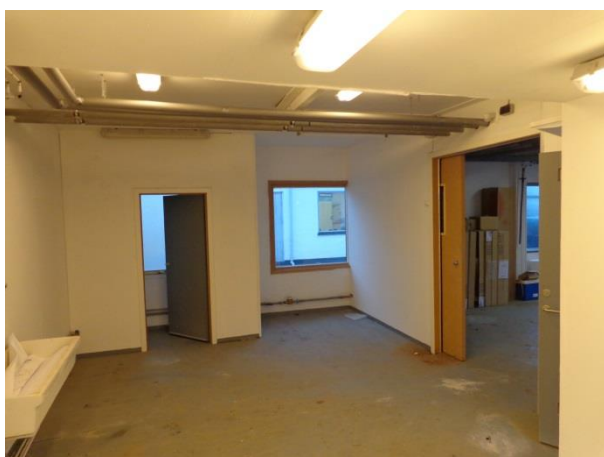
Billede 29: Dør til centralt rum i bygning I. Lille rum og vindue på nordside af bygningen.
