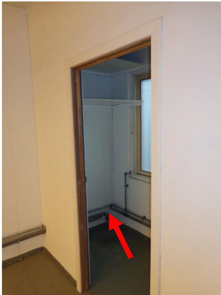
Billede 31: Dør til lille rum på nordside af bygning I (fra centralt rum). Rørgennemføringer til WC (se billede 57).
