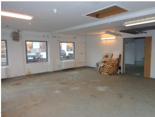
Billede 21: Østrum i bygning I. Sydvendt vinduesparti og dør til centralt rum.
