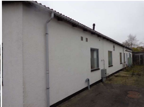
Billede 2: Nordside af bygningen.
