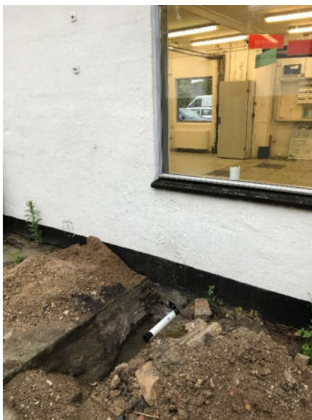
Billede 3: Ventilationsdræn u/garage (vest).
