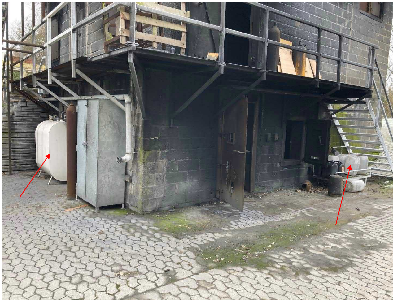
Foto 3. Nordøstlig hjørne af brandhus. Tank med Exxol til optænding står i gavlen af brandhus. Dunke med Exxol står foran brandhus, th på foto.
