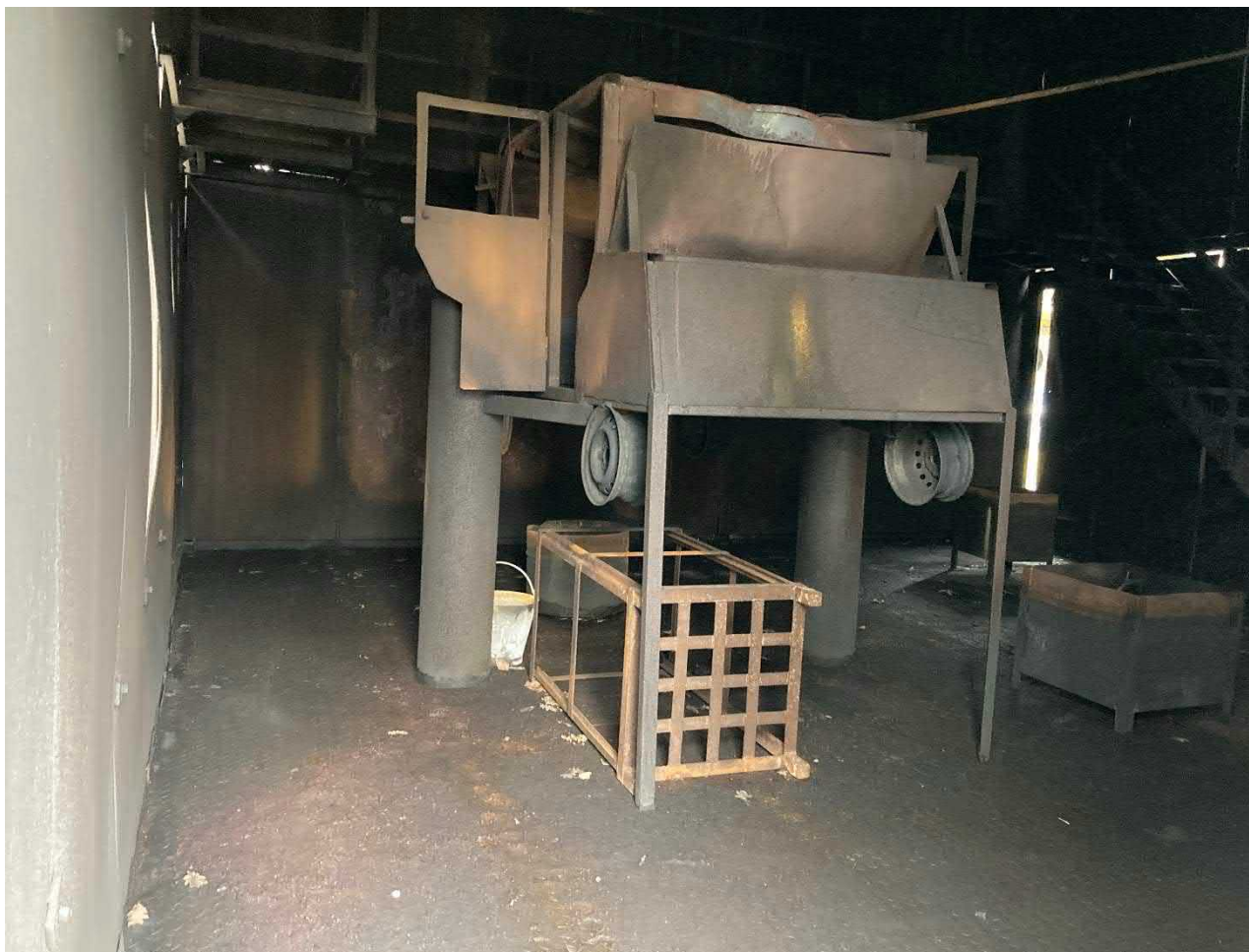
Foto 20. Foto indefra "maskinrum" i skibsskroget. Gulvet herinde var tidligere riste med et betonkar nedenunder, som der kunne tændes op i.
