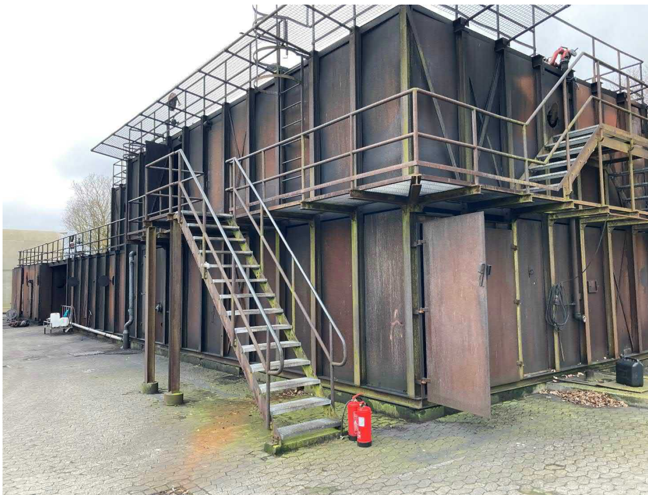
Foto 19. Skibsskrog. Øvelse i brandslukning på skibe. Dør til "Maskinrum" ses forrest i billedet (NØ hjørne af skrog).
