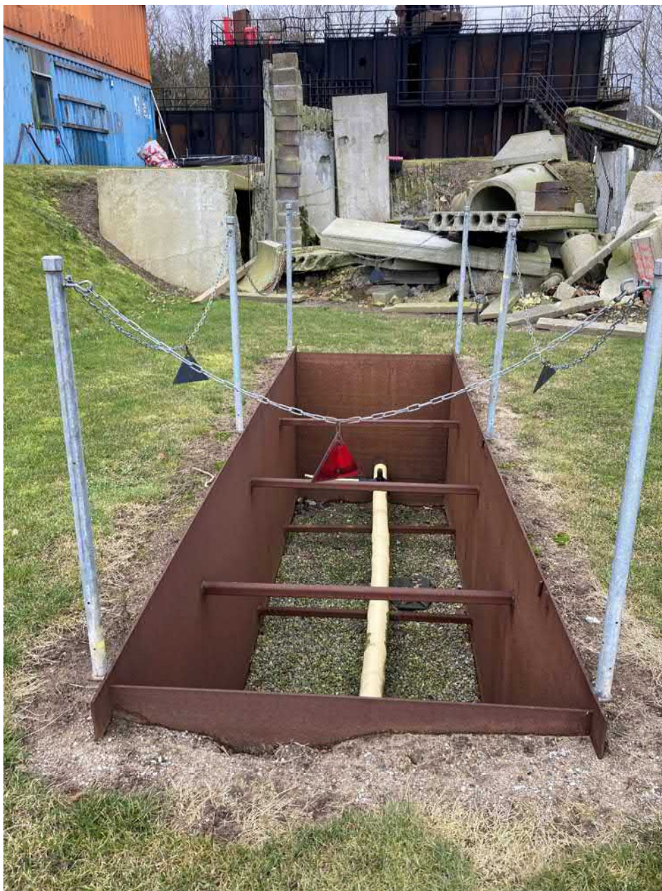
Foto 17. Øvelse i retablering af læk gasledning.
