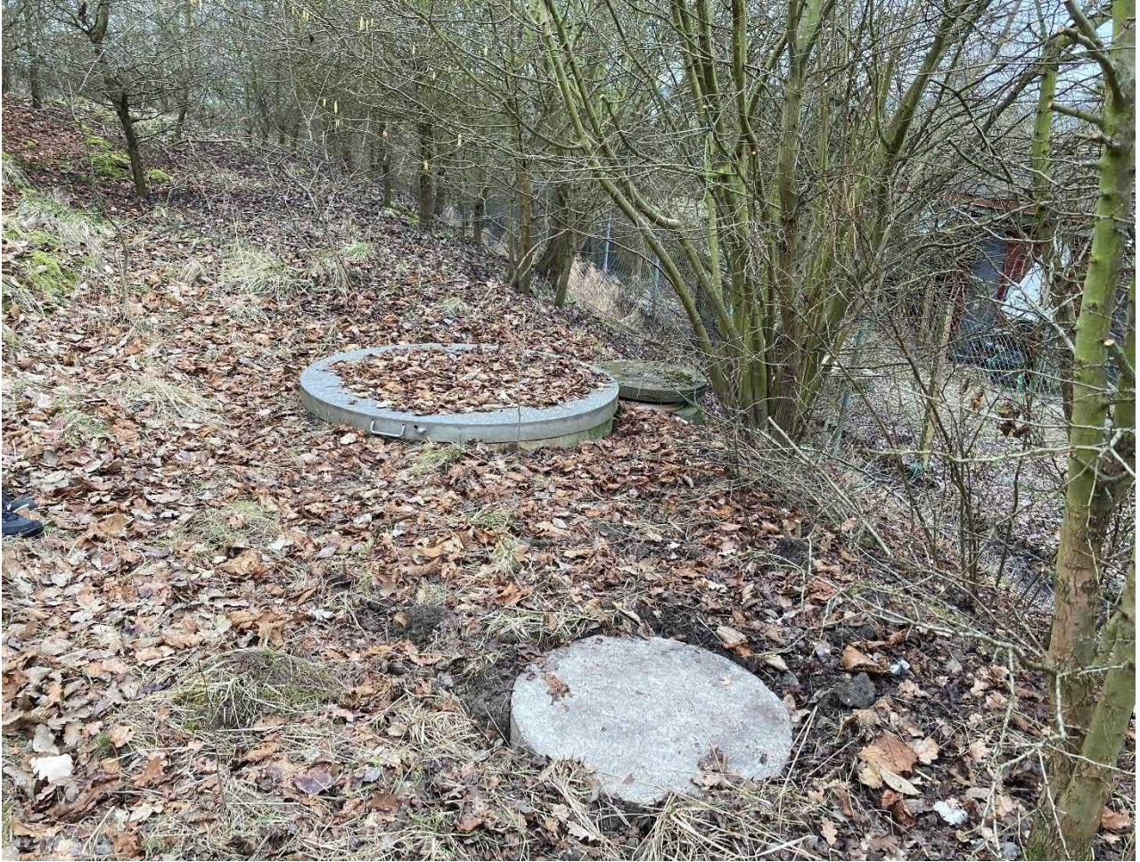
Foto 12. Olieudskiller (OU3), som overfladevand fra brandskolen passerer inden det løber ud i Noret.
