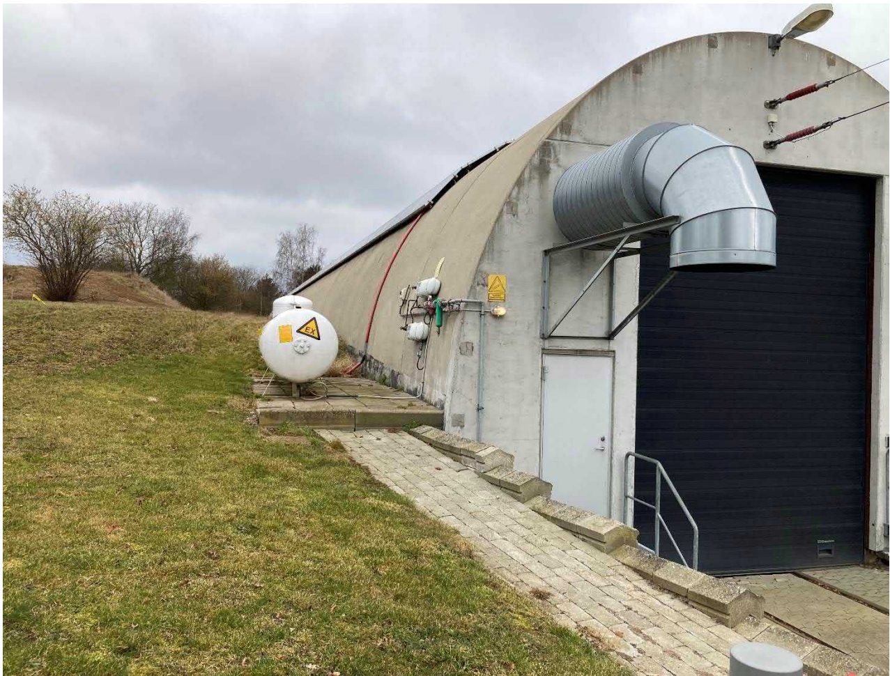
Foto 29. Gastank udenfor storebæltstunnel
