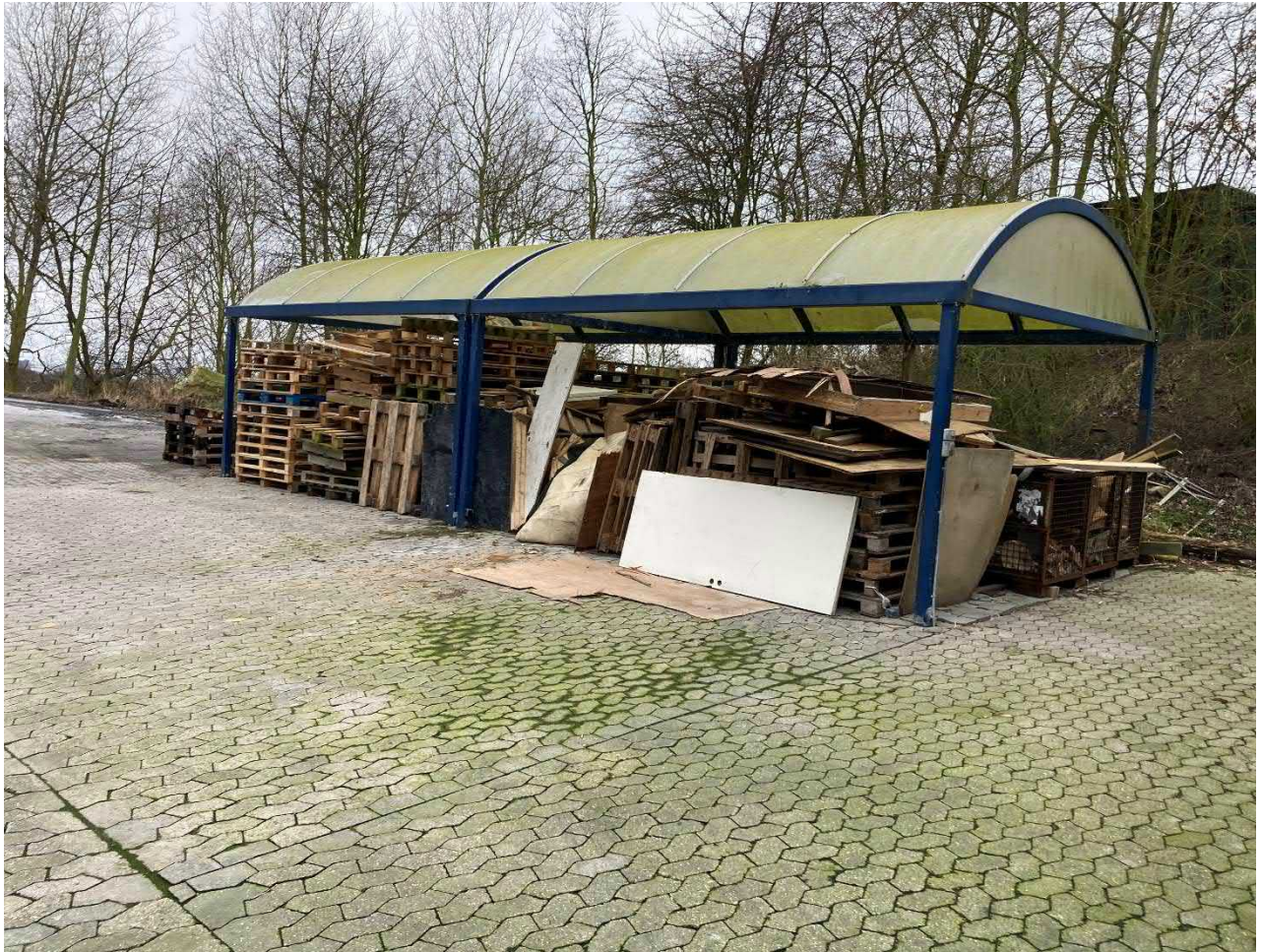
Foto 4. Skur nord for brandhus, hvor der opbevares træ til at brænde af i brandhus
