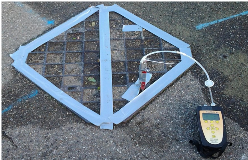
Figur 2.2 Prøvetagning af luftprøve i kloakken med prøvetagningsrør gennem hul i dæksel og måling med gasmåler.
