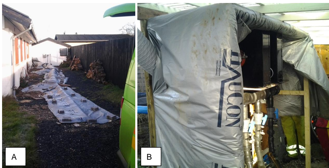
Figur 3.6: A) Afdækning med vintermåtter af Pel-rør fra ventilationsdræn til afværgeanlægget. B) Afdækning med vintermåtter af Afværgeanlægget. Forsiden af afværgeanlægget er ligeledes dækket af vintermåtter, når der ikke er tilsyn.
