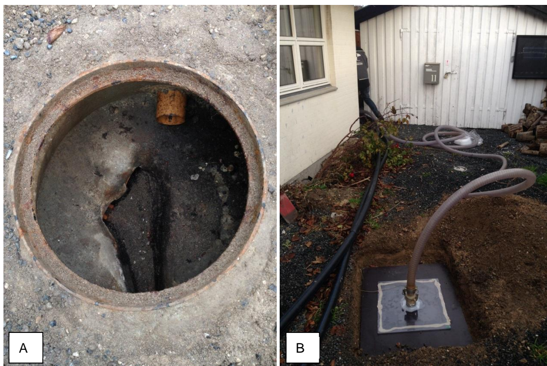
Figur 3.7: A) Samlebrønd for boligen Tujavej 11. Samlebrønden er placeret i ejendommens indkørsel. B) Forsøg med vakuumventilation af kloak (samlebrønden).
