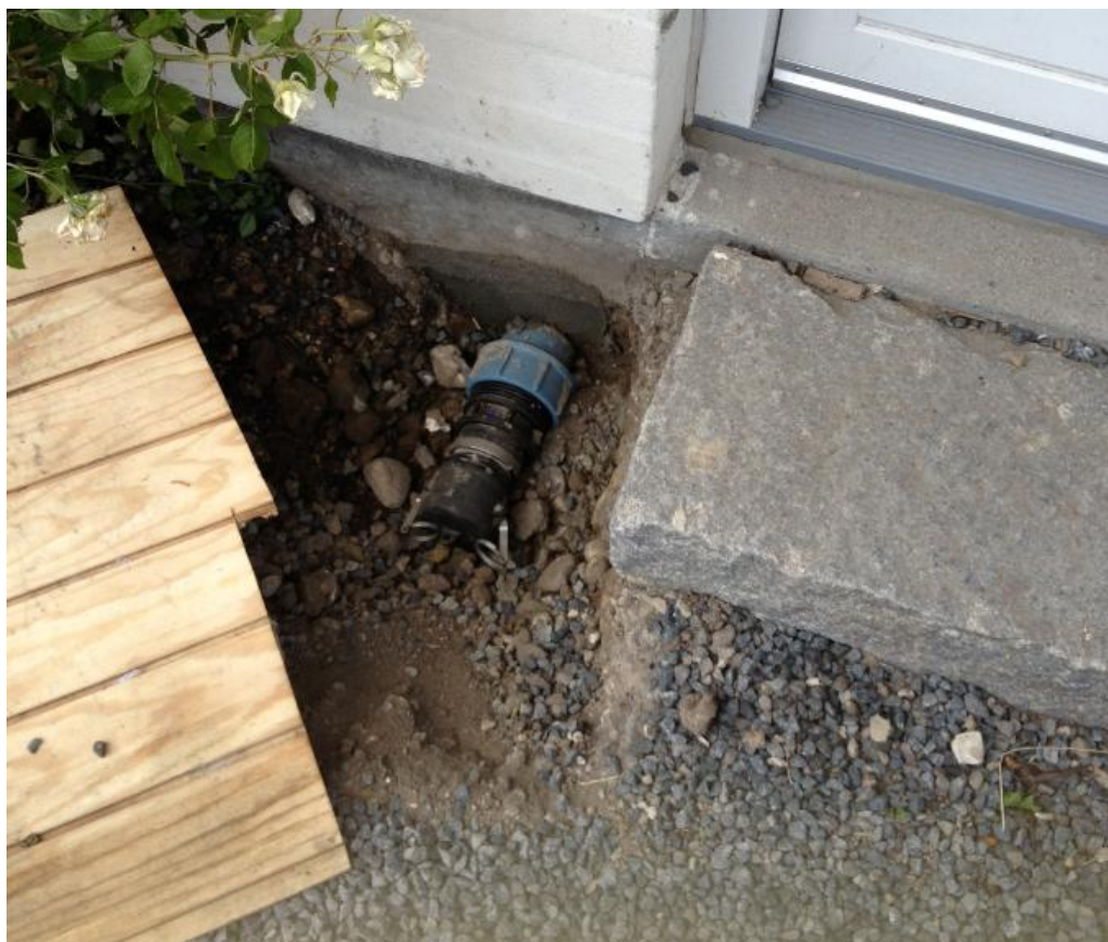
Figur 8: Afslutning af ventilationsdræn 2. Til højre ses indgangspartiet til huset.
