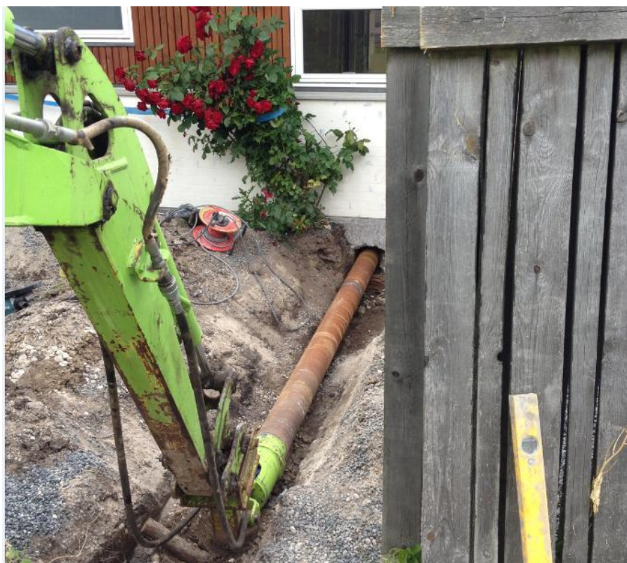
Figur 7: Snegleboring med forerør.
